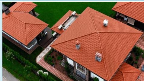
6. Сложная конструкция **многощипцовой кровли** состоит из множества частей, выступов, элементов. Пожалуй, одна из самых сложных конструкций.
